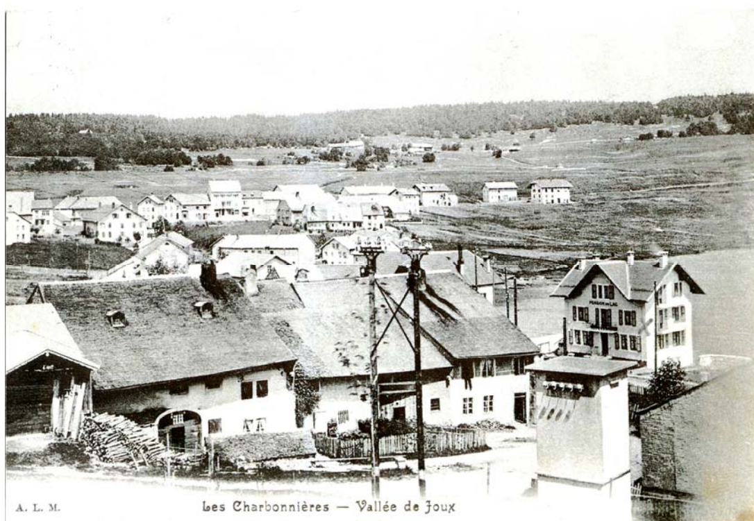
A gauche, la ferme des Golay des Crettets, avec le pont de grange accolé.
